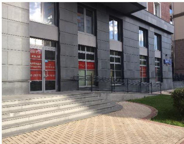
Фотография 3.1. Внешний вид здания
