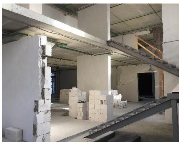
Фотография 3.6. Внутреннее состояние помещений
