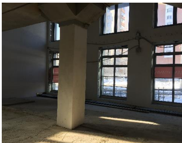
Фотография 3.3. Внутреннее состояние помещений
