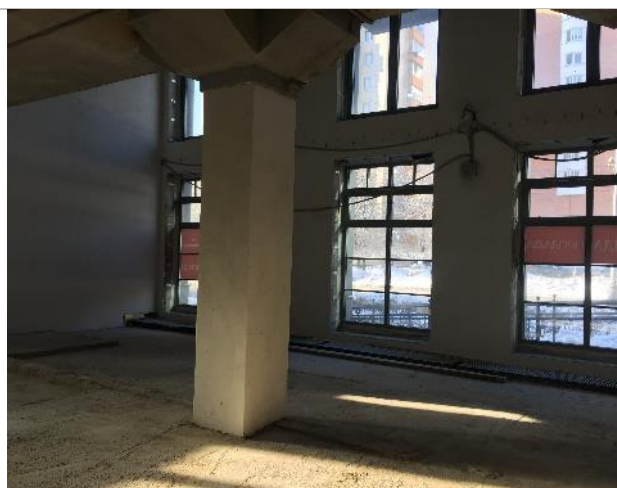
Фотография 3. Внутреннее состояние помещений
