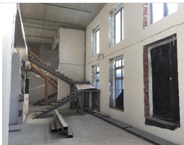
Фотография 11. Внутреннее состояние помещений
