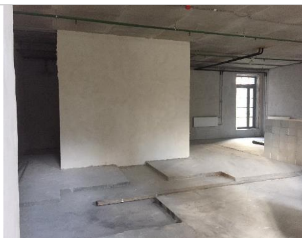
Фотография 5. Внутреннее состояние помещений
