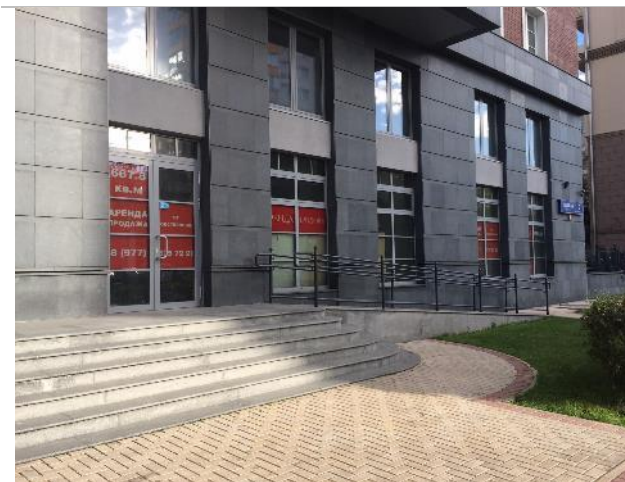
Фотография 1. Внешний вид здания
