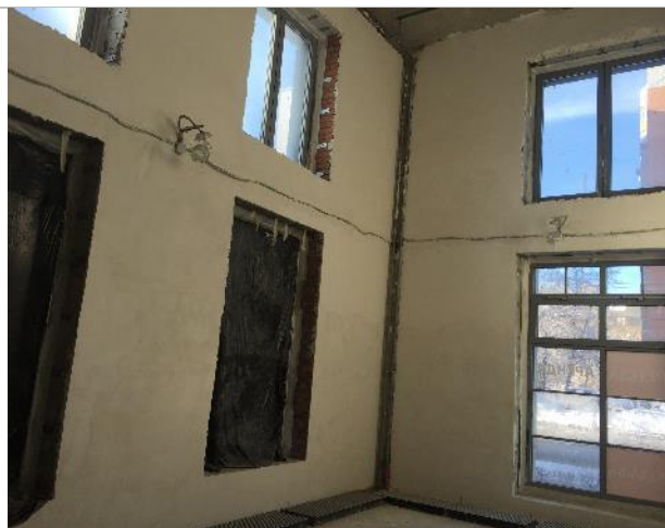
Фотография 10. Внутреннее состояние помещений
