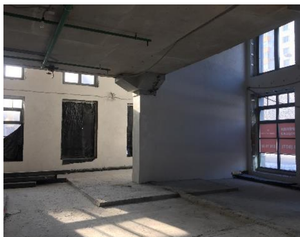
Фотография 3.4. Внутреннее состояние помещений
