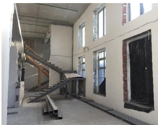
Фотография 3.5. Внутреннее состояние помещений
