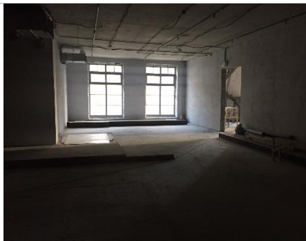
Фотография 7. Внутреннее состояние помещений
