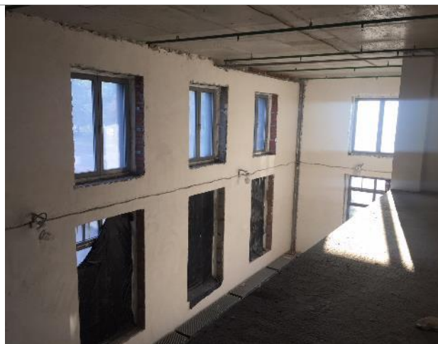
Фотография 13. Внутреннее состояние помещений
