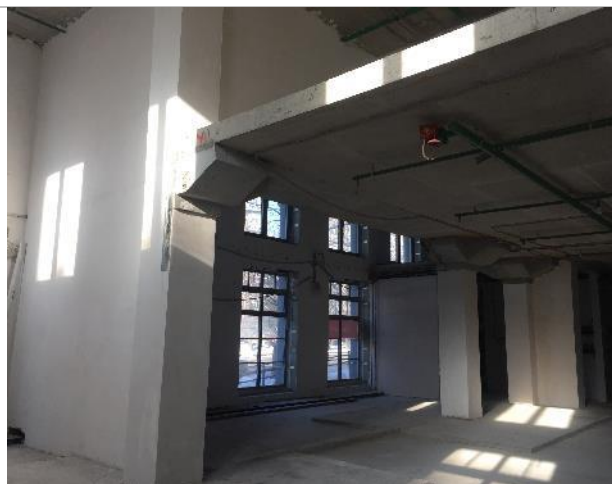
Фотография 8. Внутреннее состояние помещений
