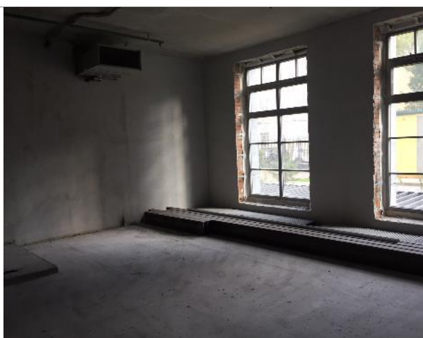
Фотография 6. Внутреннее состояние помещений
