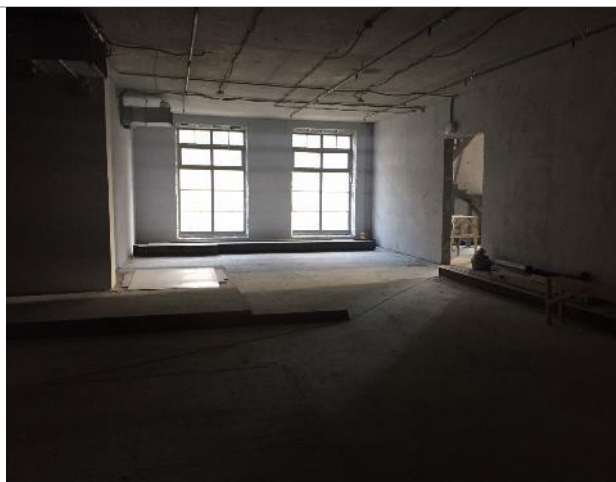
Фотография 7. Внутреннее состояние помещений
