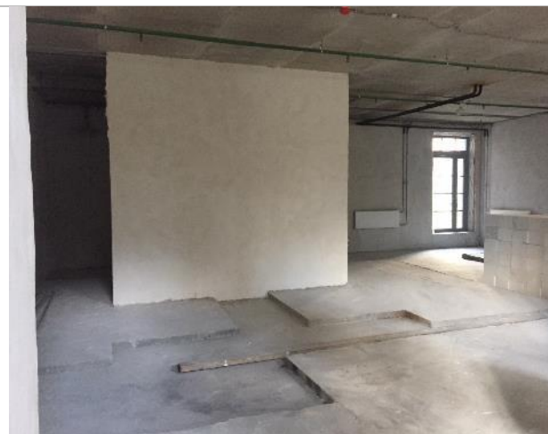
Фотография 5. Внутреннее состояние помещений
