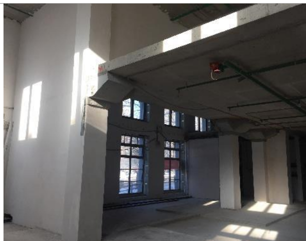
Фотография 8. Внутреннее состояние помещений
