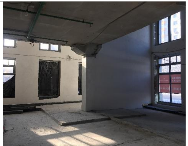
Фотография 4. Внутреннее состояние помещений
