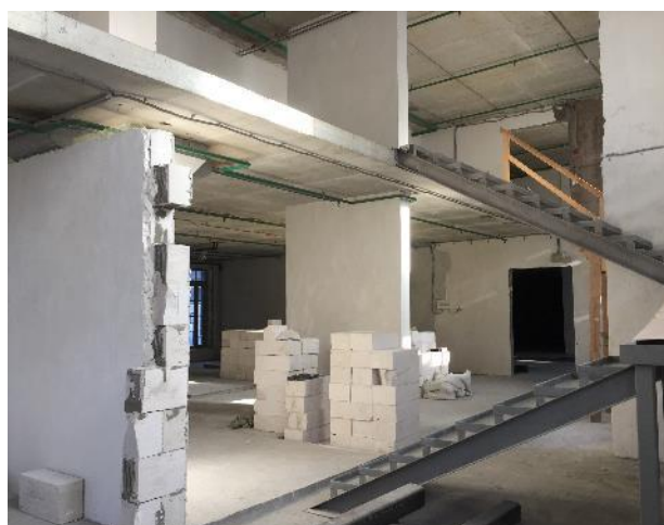
Фотография 3.6. Внутреннее состояние помещений
