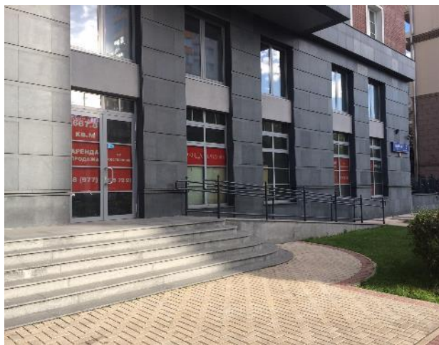
Фотография 3.1. Внешний вид здания
