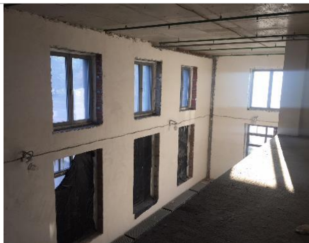
Фотография 13. Внутреннее состояние помещений
