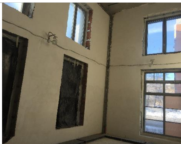
Фотография 10. Внутреннее состояние помещений
