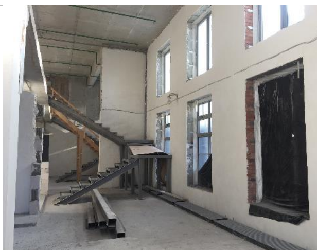
Фотография 11. Внутреннее состояние помещений
