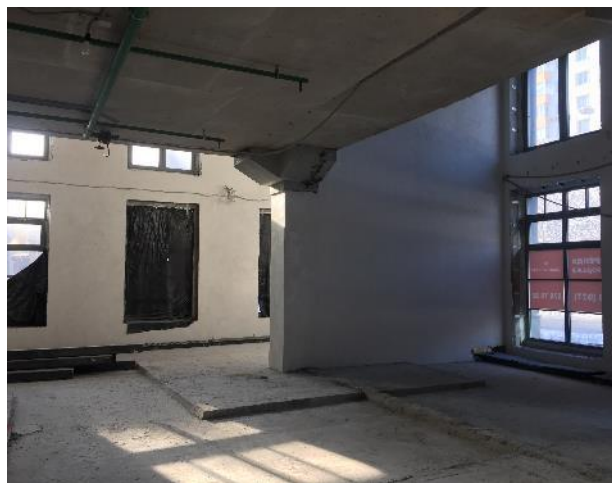
Фотография 3.4. Внутреннее состояние помещений
