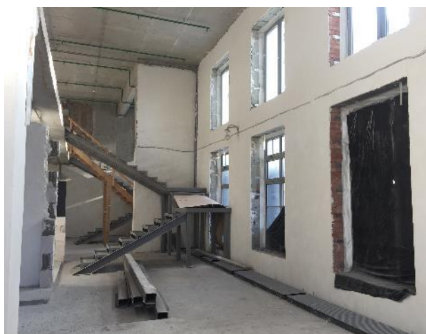
Фотография 3.5. Внутреннее состояние помещений
