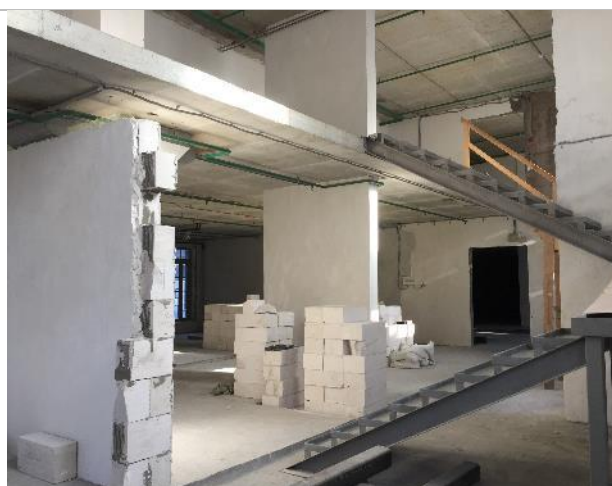
Фотография 12. Внутреннее состояние помещений
