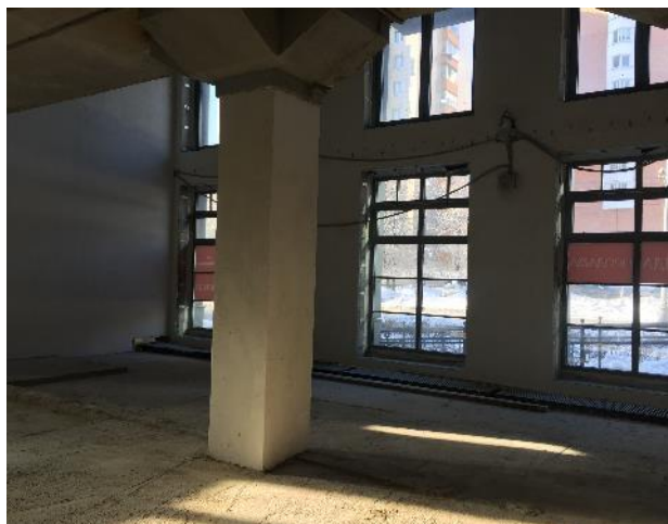
Фотография 3.3. Внутреннее состояние помещений
