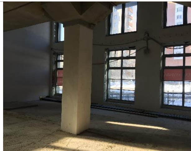
Фотография 3. Внутреннее состояние помещений
