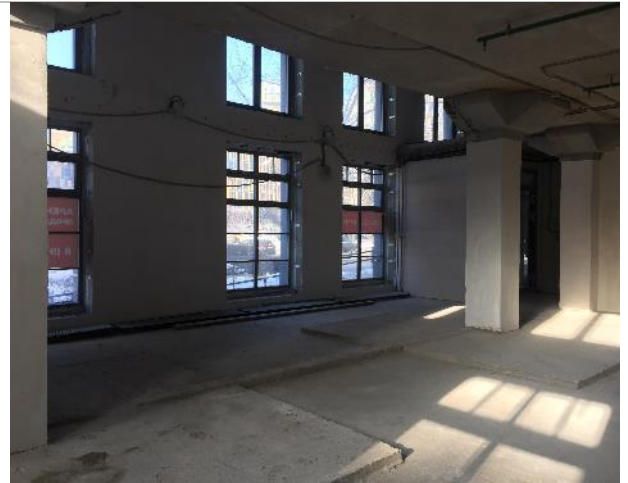
Фотография 2. Внутреннее состояние помещений
