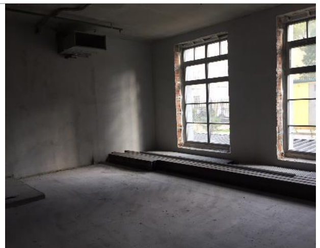
Фотография 6. Внутреннее состояние помещений
