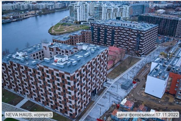
Фотография 3.2. Жилой дом по адресу г. Санкт-Петербург, пр. Петровский, д. 11, корп. 3
