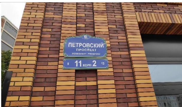
Фотография 3.5. Жилой дом по адресу г. Санкт-Петербург, пр. Петровский, д. 11, корп. 2
