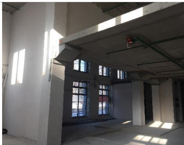
Фотография 8. Внутреннее состояние помещений
