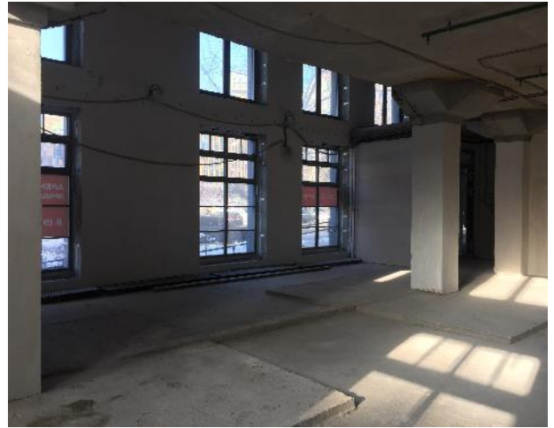
Фотография 3.2. Внутреннее состояние помещений
