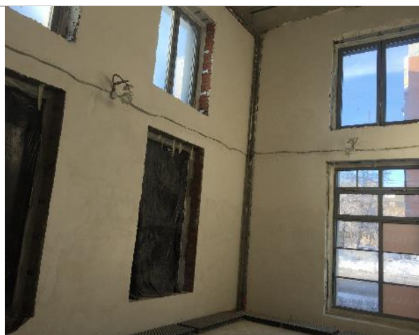
Фотография 10. Внутреннее состояние помещений
