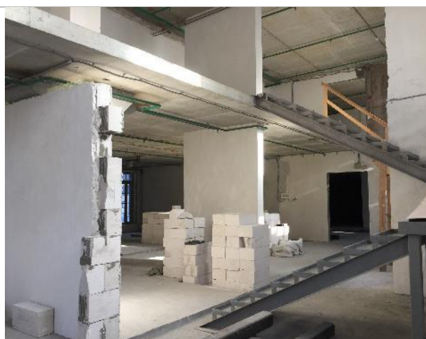
Фотография 12. Внутреннее состояние помещений
