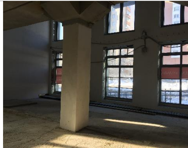
Фотография 3. Внутреннее состояние помещений
