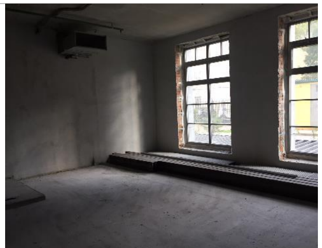
Фотография 6. Внутреннее состояние помещений
