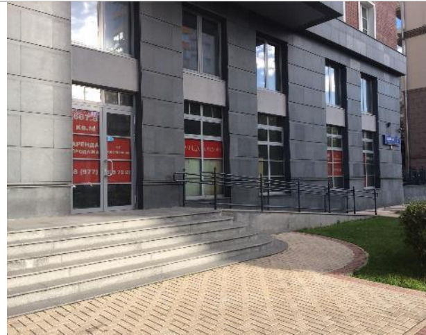
Фотография 1. Внешний вид здания
