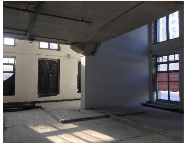
Фотография 4. Внутреннее состояние помещений
