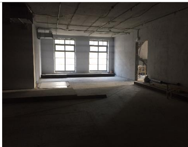
Фотография 7. Внутреннее состояние помещений
