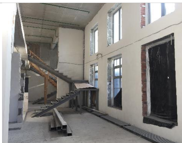
Фотография 11. Внутреннее состояние помещений
