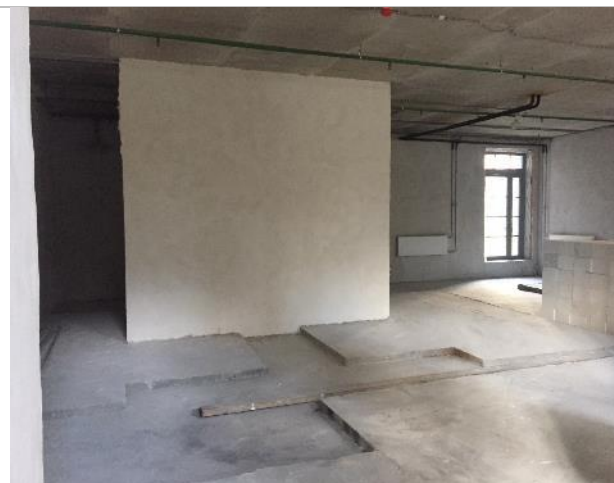
Фотография 5. Внутреннее состояние помещений
