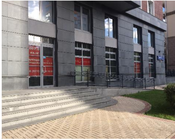
Фотография 3.1. Внешний вид здания
