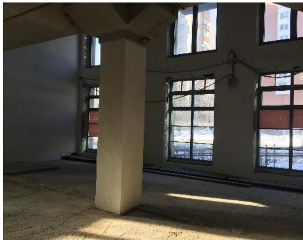
Фотография 3.3. Внутреннее состояние помещений
