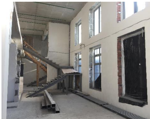
Фотография 3.5. Внутреннее состояние помещений
