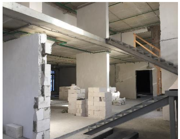
Фотография 3.6. Внутреннее состояние помещений
