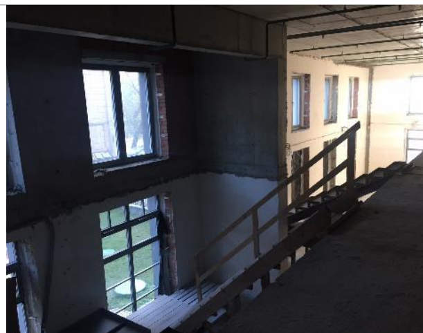
Фотография 14. Внутреннее состояние помещений
